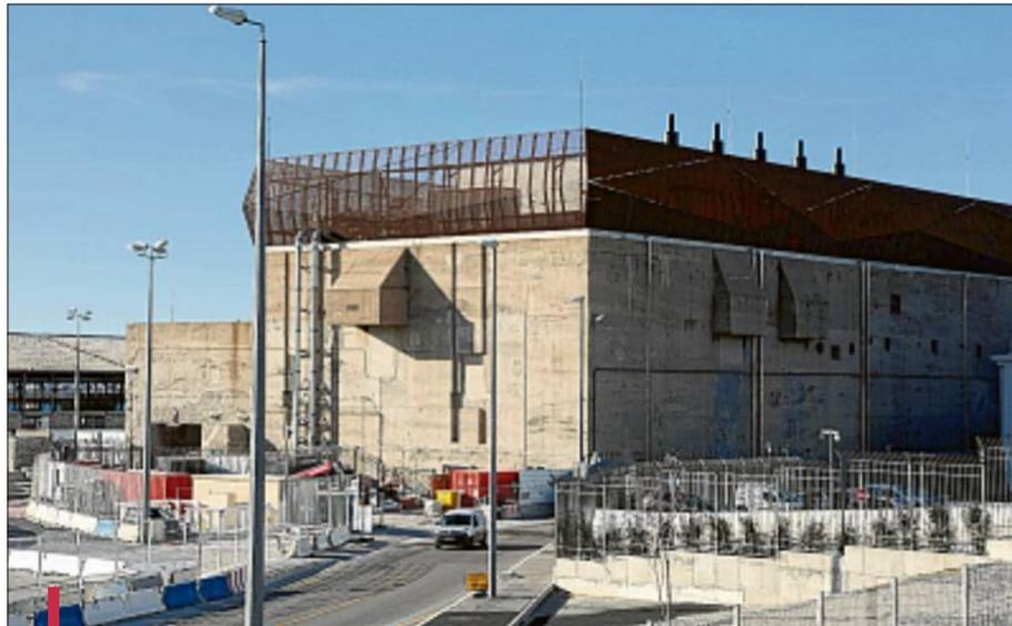
À l'abandon pendant de nombreuses années, cette ancienne base allemande de sous-marins est quasi-indestructible. Doté d'un toit en béton armé de 5,5 m d'épaisseur pour se protéger des bombes et d'une longueur de 250 m, avec un mur d'enceinte de 12 m de haut, ce bâtiment atypique a été transformé en une véritable forteresse numérique. /PHOTO VALÉRIE VREL
