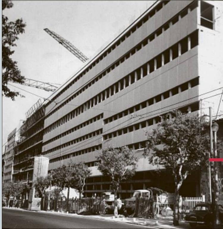
Le bâtiment multi-activités de la Ville lors de sa construction en 1968. L'ossature de béton armé de la façade sera recouverte de graviers lavés. / PHOTO ARCHIVES LP
